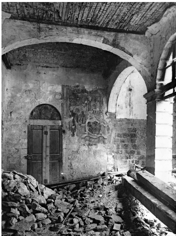
1. Detajl križnega hodnika nekdanjega samostana sv. Frančiška v Kopru (danes Gimnazija Koper) z ostanki poslikav, oktober 1939
