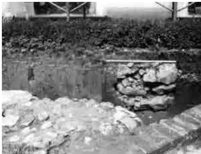
2. Stična, cistercijski samostan, temelj opornika ob južni atrijski steni križnega hodnika / Stična, Cistercian monastery, foundation of a buttress alongside the south atrium wall of the cloister
