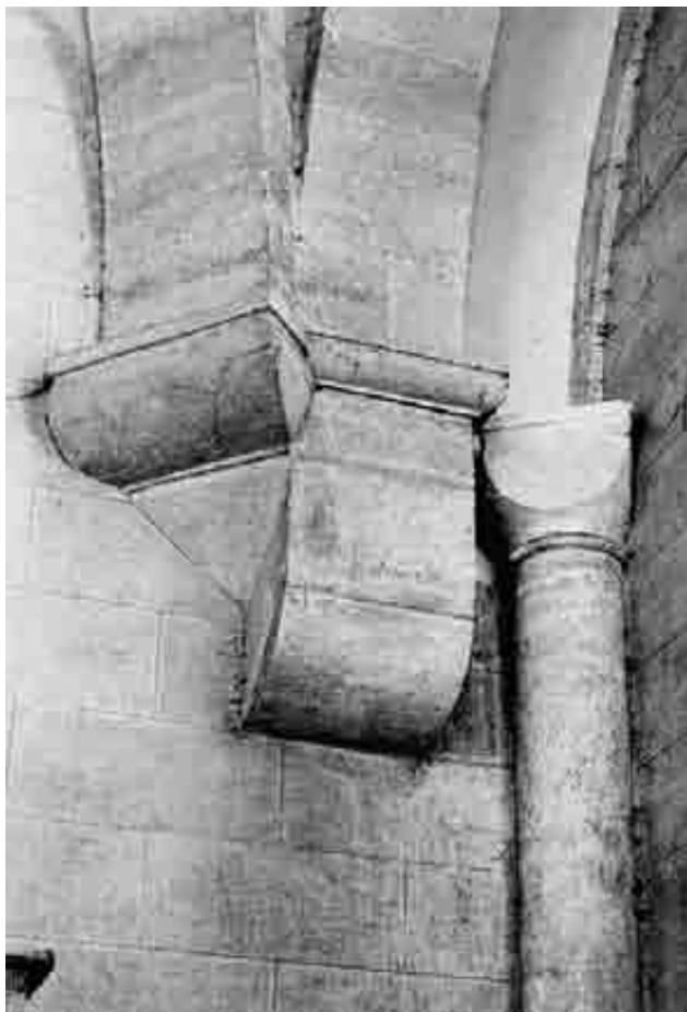
16. Heiligenkreuz, cistercijska cerkev, iztek reber v severozahodnem kotu prečne ladje / Heiligenkreuz, Cistercian church, end of the ribs in the northwest corner of the transept
